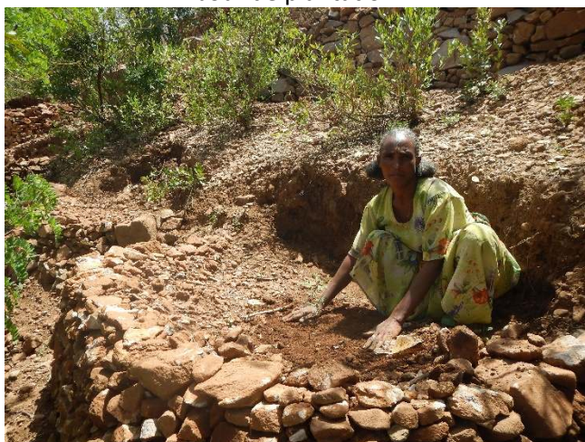
Construction des « eye-brows »
